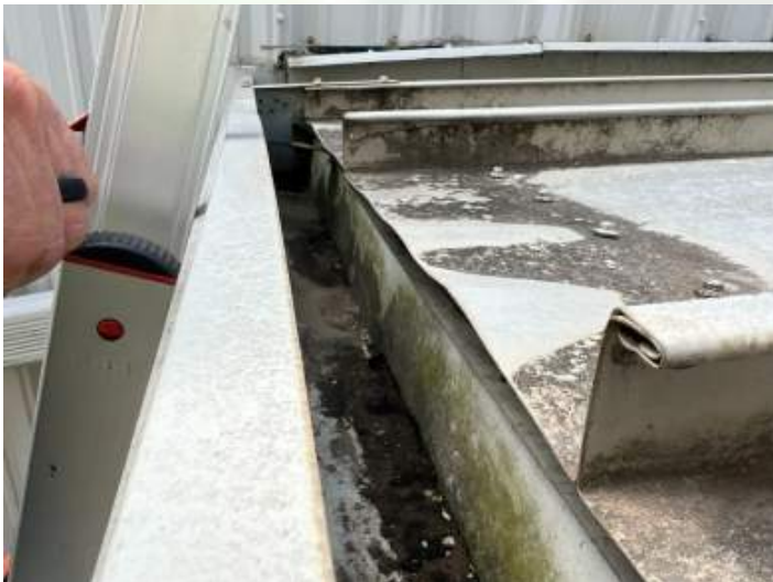
Gutter edge view
