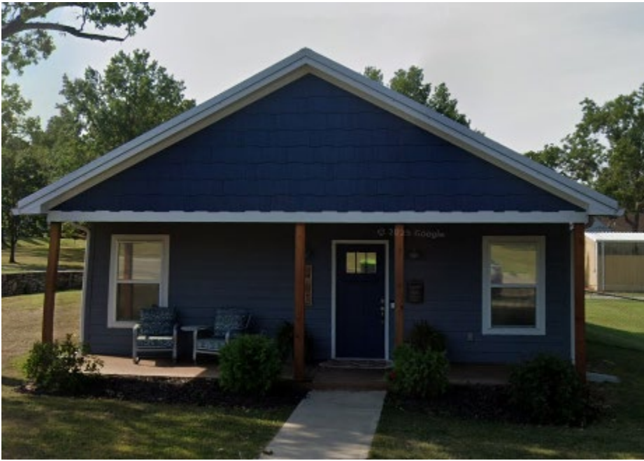
901 W. Mechanic St.:
