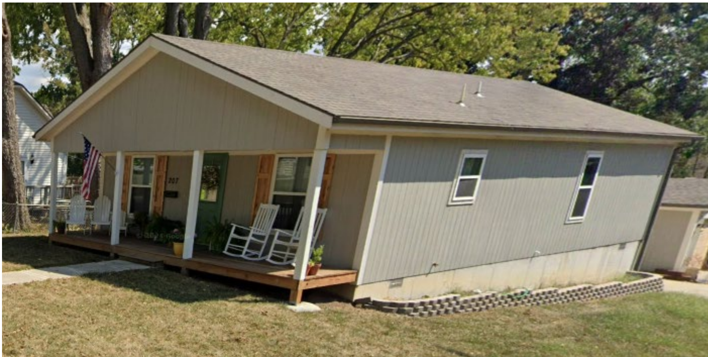
207 W. Mechanic St.:
